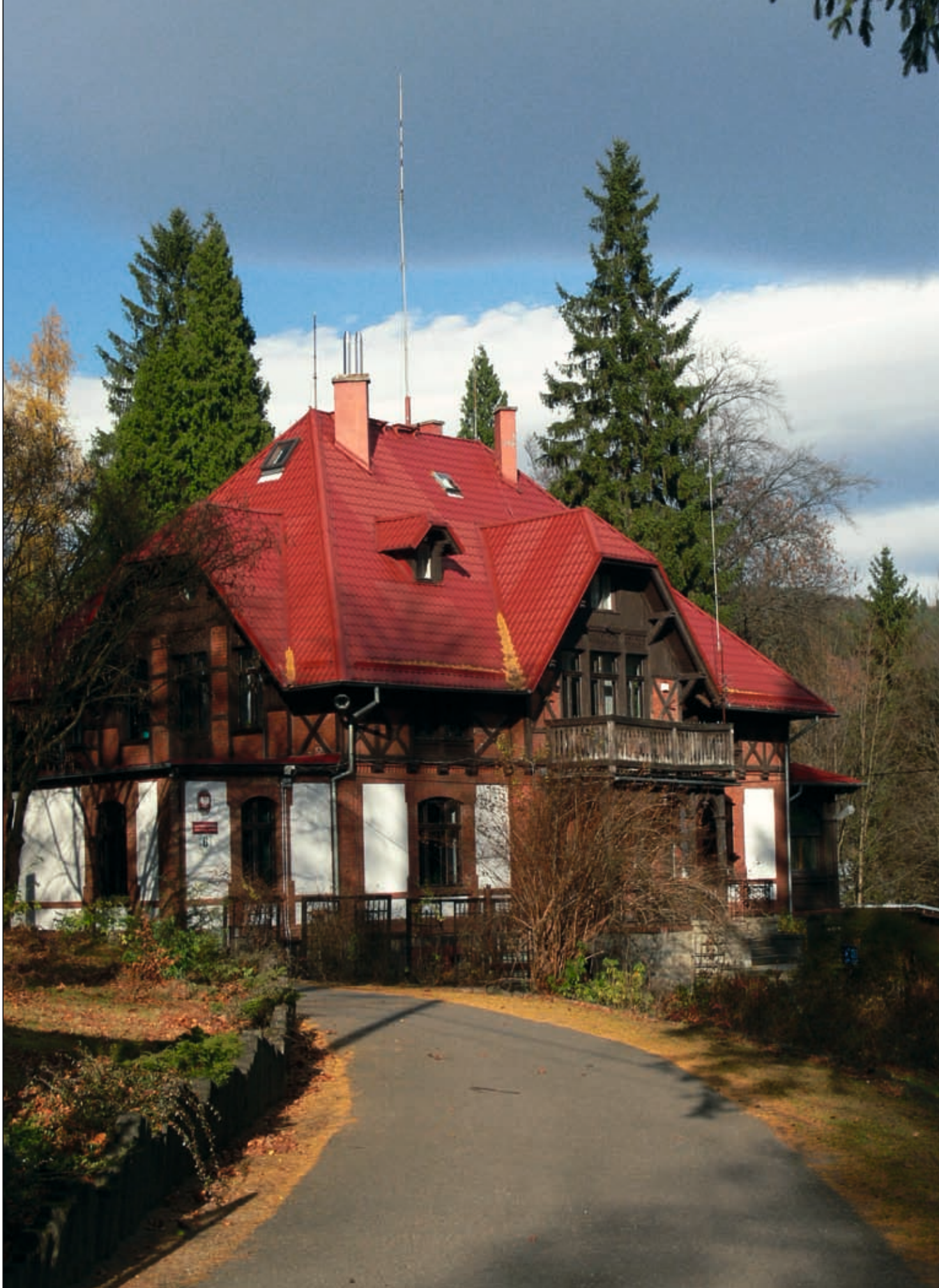
Budynek nadleśnictwa przy ulicy Krasińskiego 6
