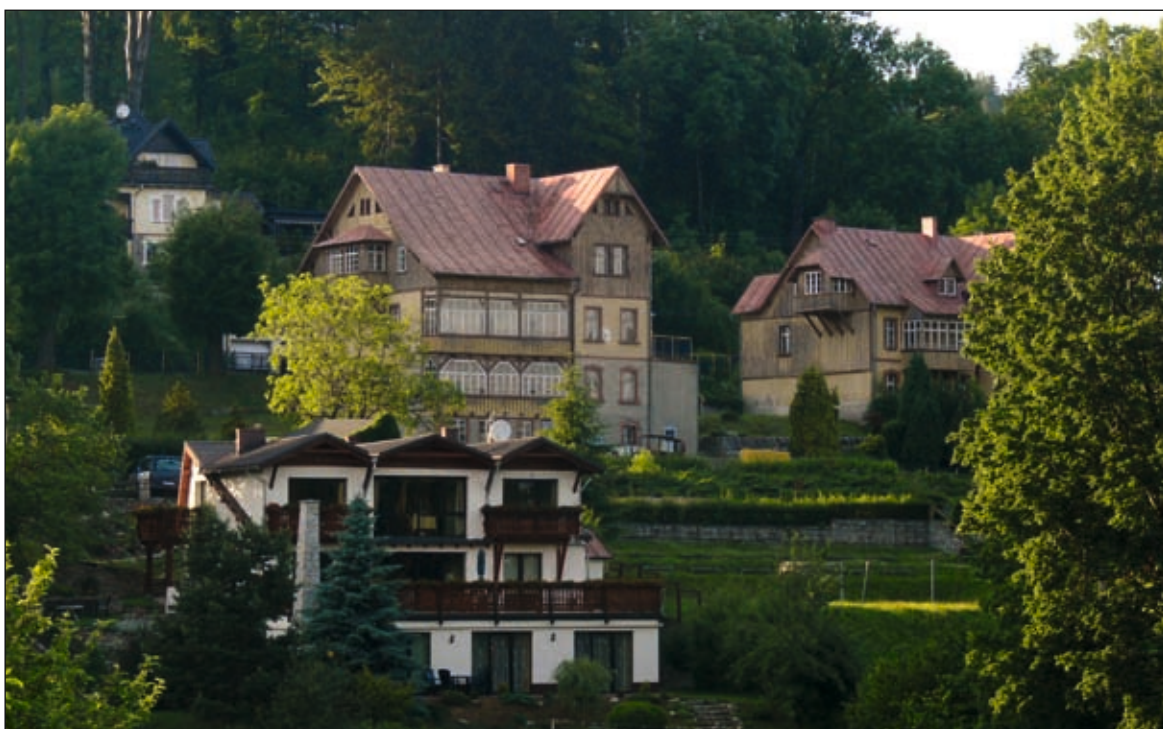
Zabudowa ulicy Kolejowej
