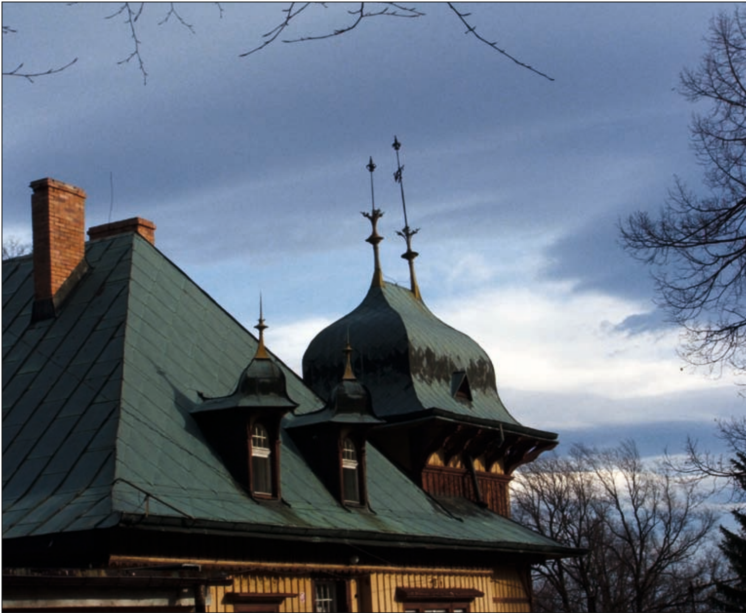
Jeden z pensjonatów przy ulicy Odrodzenia
