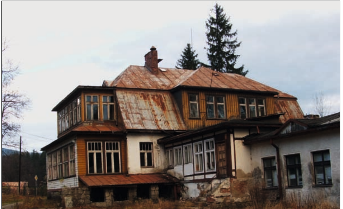
Ulica Kilińskiego – budynki dawnego sanatorium przeciwgruźliczego
